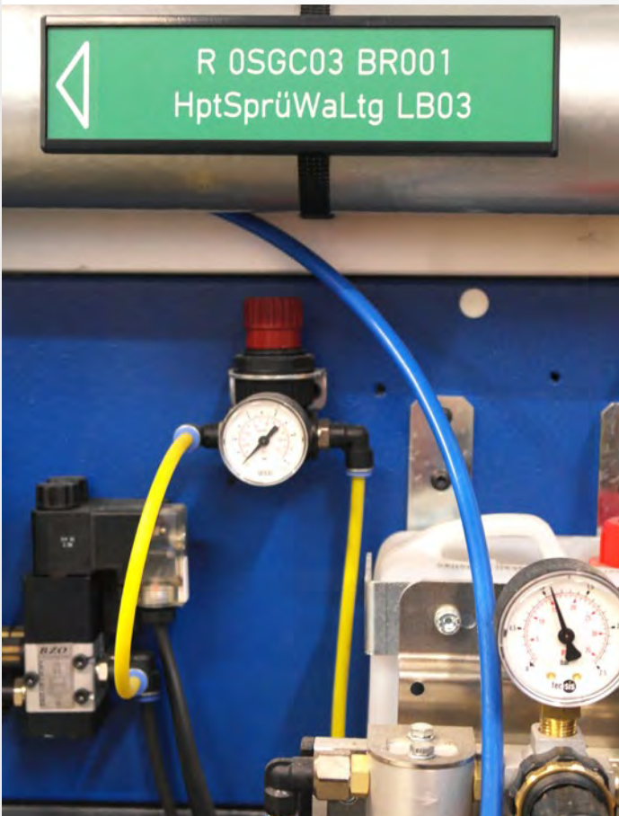
Montagebeispiel Rohrleitungsschild
